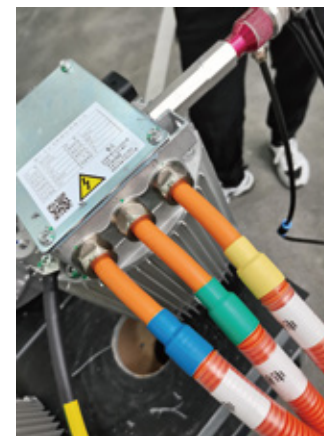
▲ 现场装机气密测试
